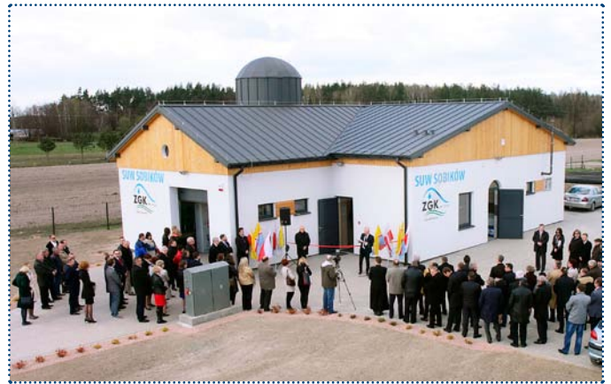
Obiekt stacji uzdatniania wody Sobików
